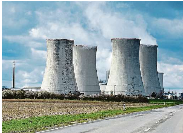
Tepl pro Brno Zdrojem tepla pro horkovod bude Jaderná elektrárna Dukovany
